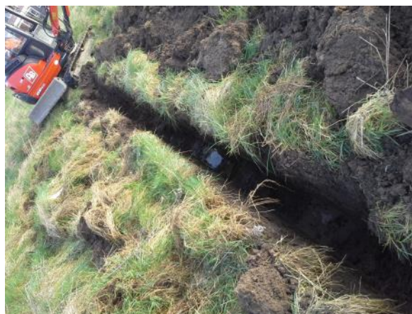
Foto 2: Sleuf 1 in gedempte sloot
