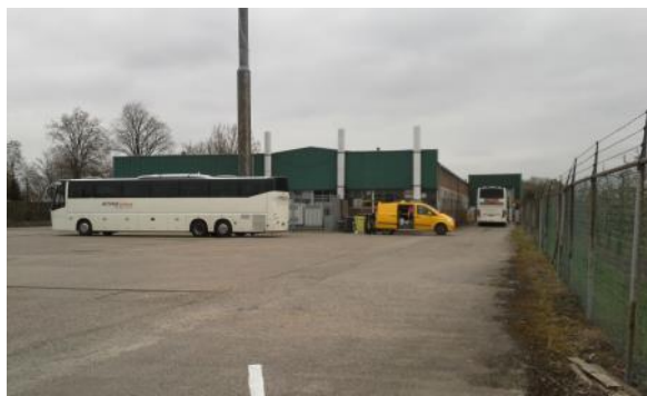
Foto 5: Achterzijde busremise met gelegenheid voor het stallen van voertuigen (2)
