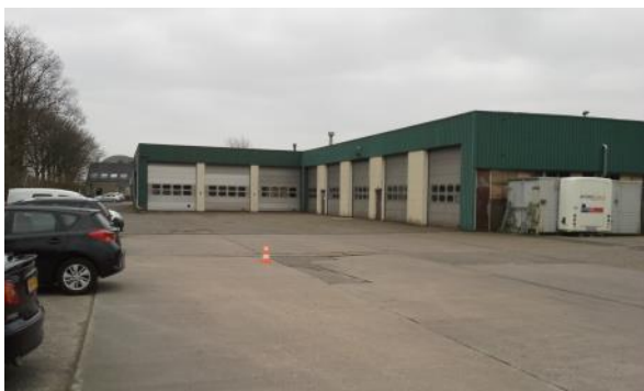
Foto 4: Achterzijde busremise met gelegenheid voor het stallen van voertuigen (1)
