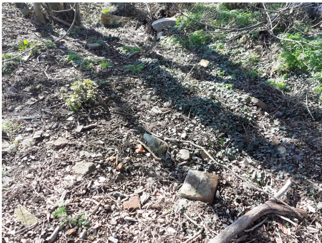
Afb. 4 Impressie van het aanwezige puin in het plangebied
