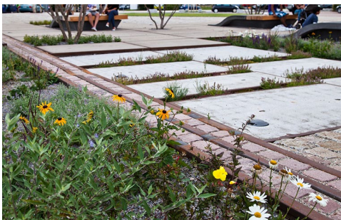
Oude elementen (rails) opnemen in bestrating
