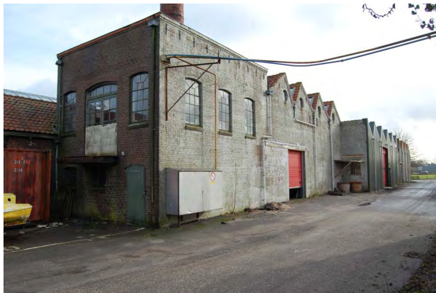
Overzicht van de Oostgevel van gebouw E.
