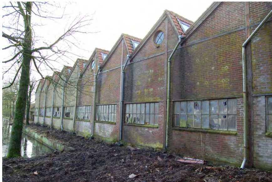
Overzicht van de oostgevel van de bouwdelen B, C en D.
