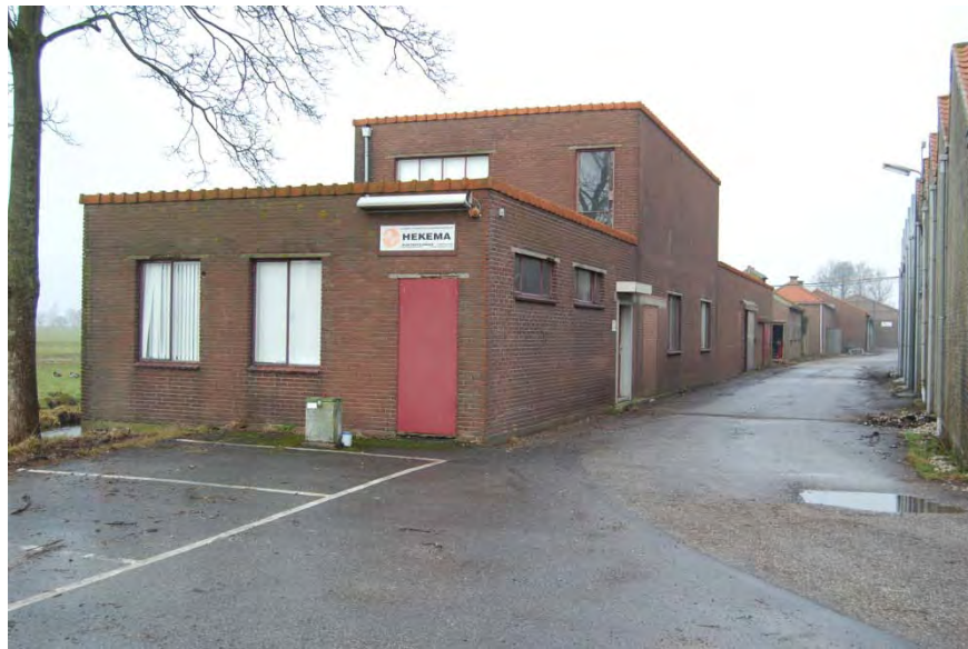
Overzicht van gebouw T, gezien vanuit het zuiden.
