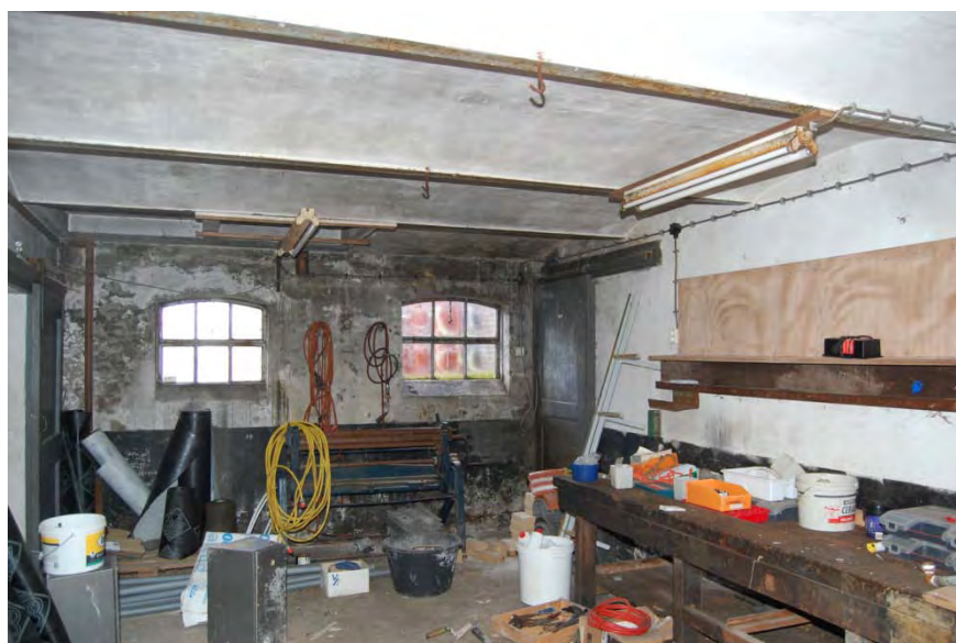
Interieur van de begane grond, gezien naar het noorden.
