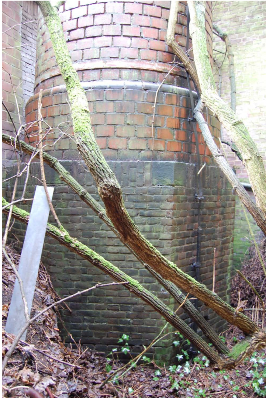
Voet van de schoorsteen
