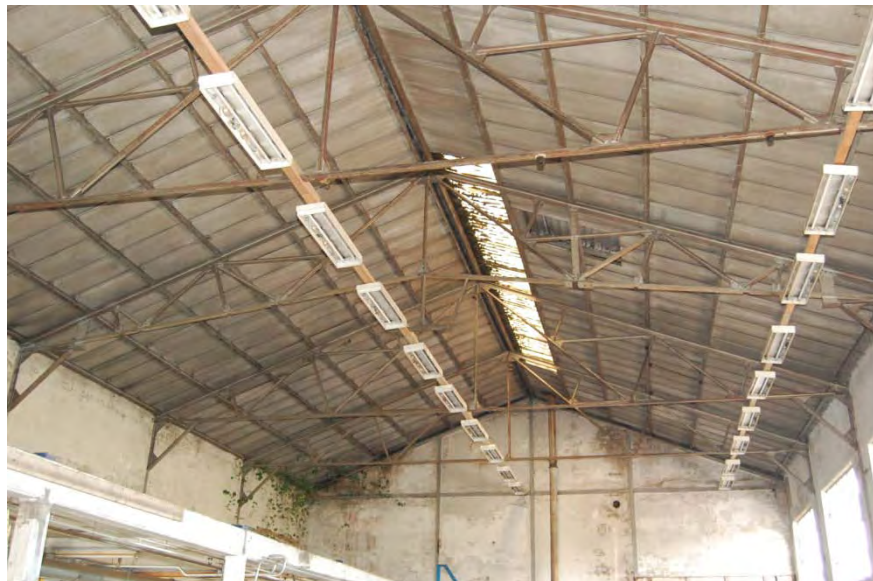
Overzicht van de kapconstructie, gezien naar het noorden. Het middelste spant heeft een afwijkende vorm.
