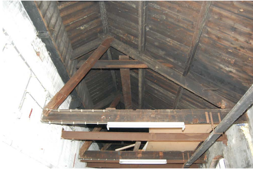
Overzicht van de kapconstructie, gezien naar het zuiden. De oorspronkelijke A-spanten zijn aan de linkerkant ingekort en voorzien van een steek-schoor.
