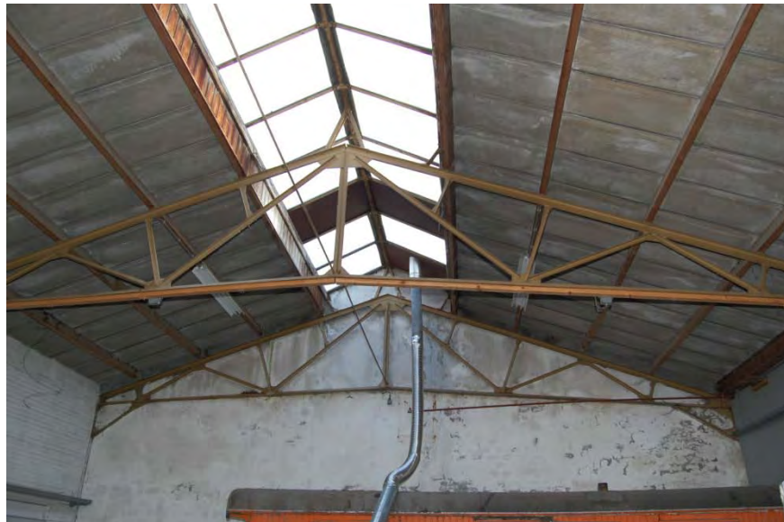
Overzicht van de kapconstructie, gezien naar het zuiden.
