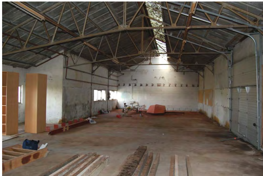
Overzicht van het zuidelijke deel van gebouw Q (Q-3), gezien naar het noorden. Kenmerkend zijn de asymmetrische Belgische spanten.
