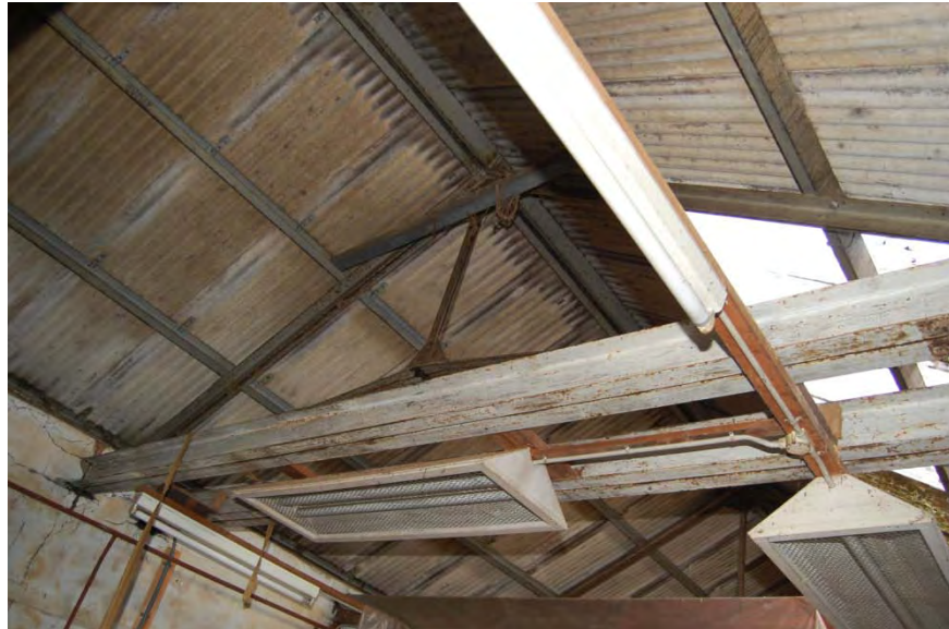
Kapconstructie, waaronder de stalen balken voor de teermachine.
