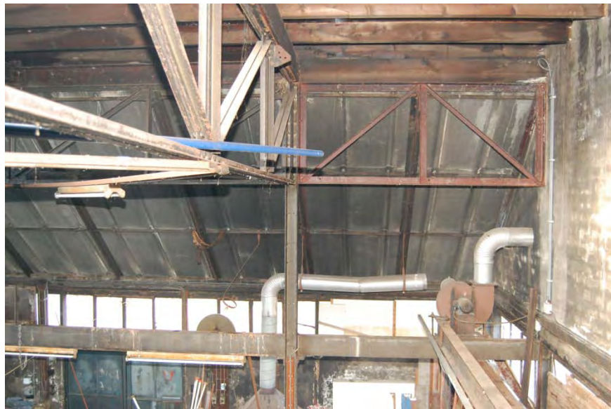
Overzicht van de constructie met kolom en vakwerkliggers. Rechts op de foto is het verlengde dakvlak van het westelijke dakschild zichtbaar, waarvoor ook de vakwerkconstructie is verlengd.
