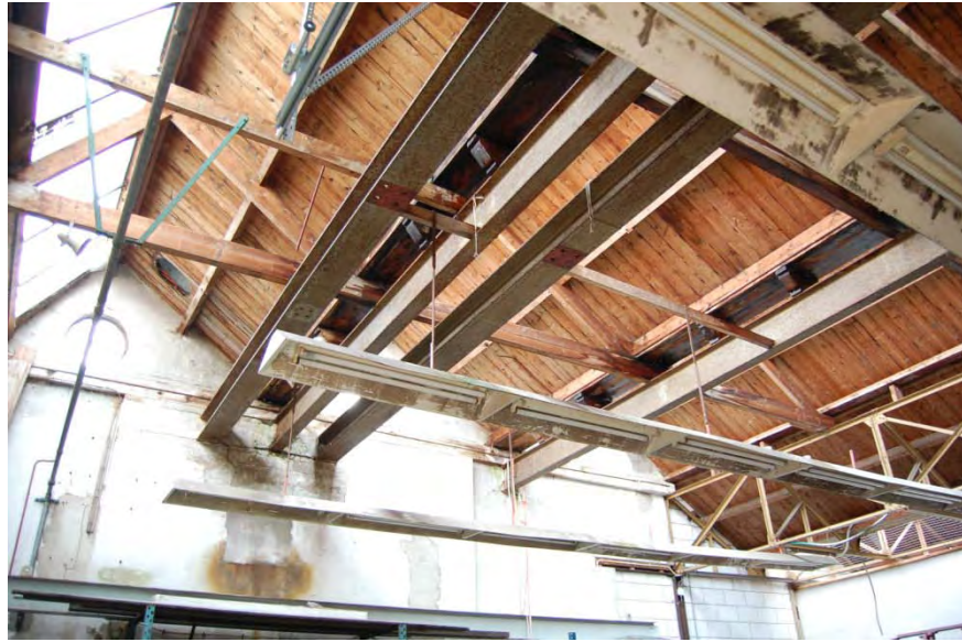
Kapconstructie in de fabriekshal van gebouw E.
