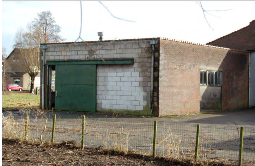
Noord- en westgevel.
