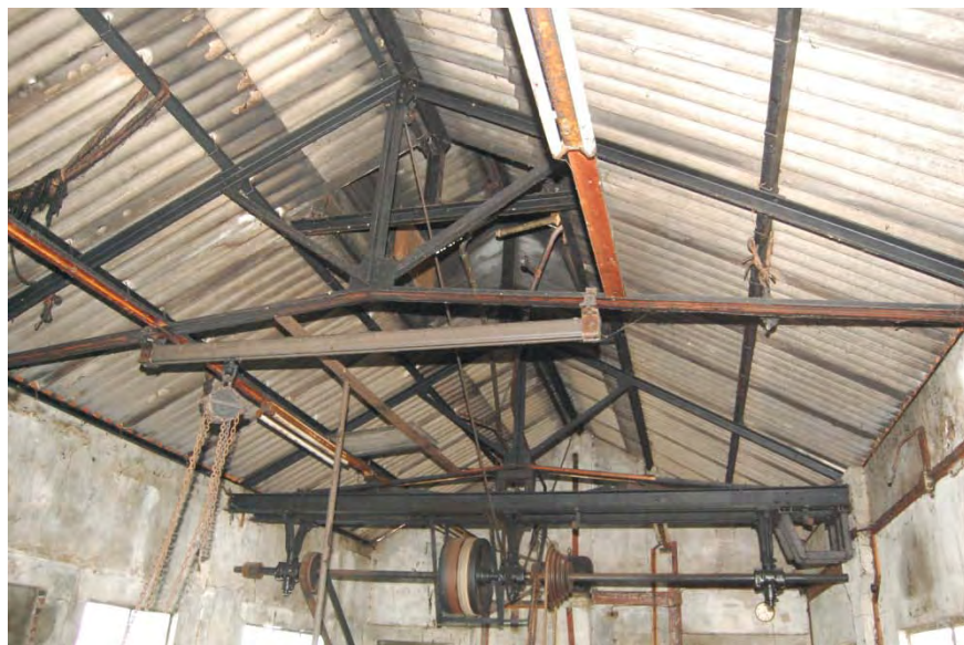
Overzicht van de kapconstructie.
