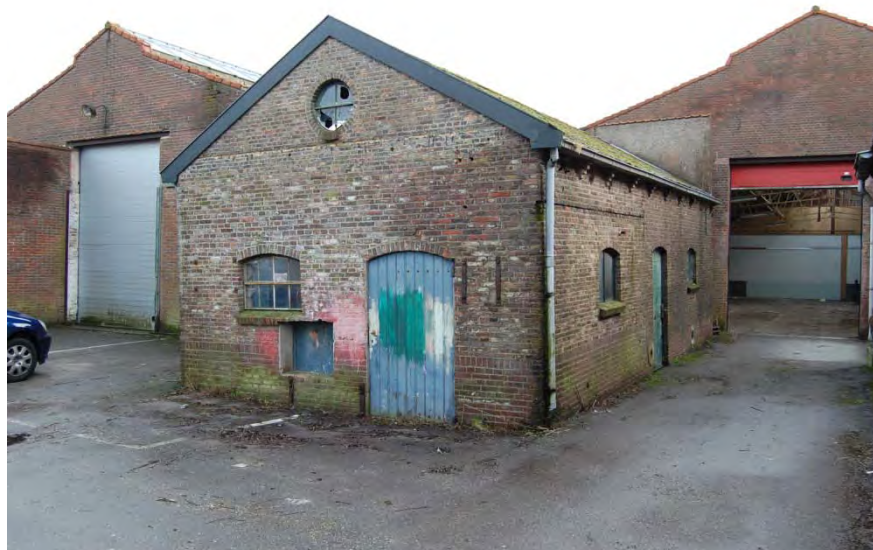
Noord- en westgevel.
