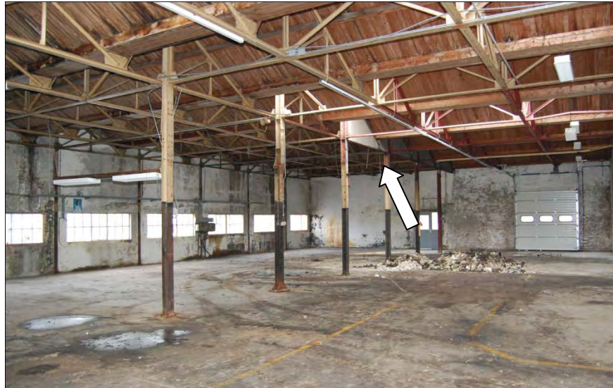
Overzicht van de beuken C en D, gezien naar het zuiden. Het gedeelte linksachter is de touwslagafdeling uit 1948. De kolommenrij was deels ingevuld met muurwerk, zoals nog valt te zien bij de sheddaken (pijl).
