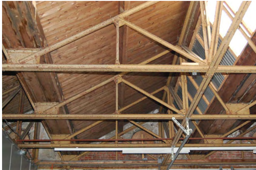
Overzicht van de geklonken spanten in beuk B (circa 1925).
