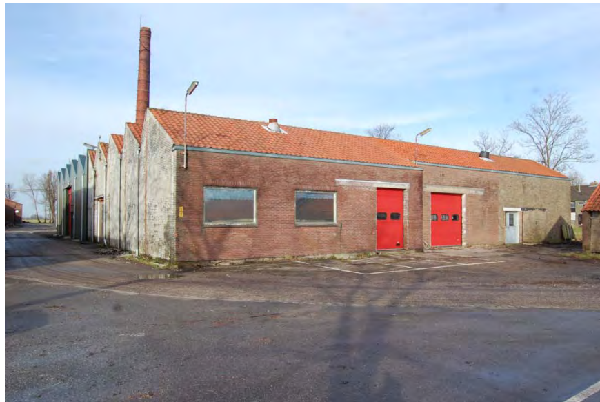
Overzicht van de zuidgevel van de bouwdelen B, C en D.
