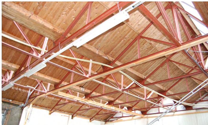
De vernieuwde spanten in het zuidelijkste deel van beuk B.
