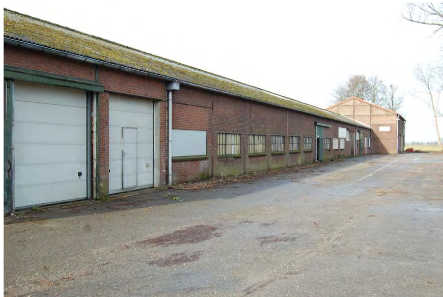
Oostgevel van gebouw Q. Op de achtergrond is gebouw R herkenbaar.
