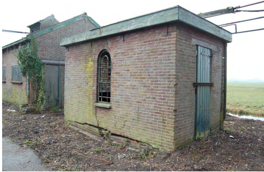
Oost- en noordgevel.
