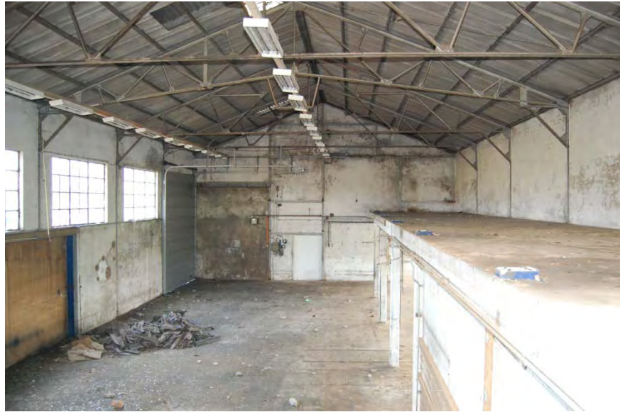
Overzicht van het interieur, gezien naar het zuiden. Rechts de betonnen entresol.
