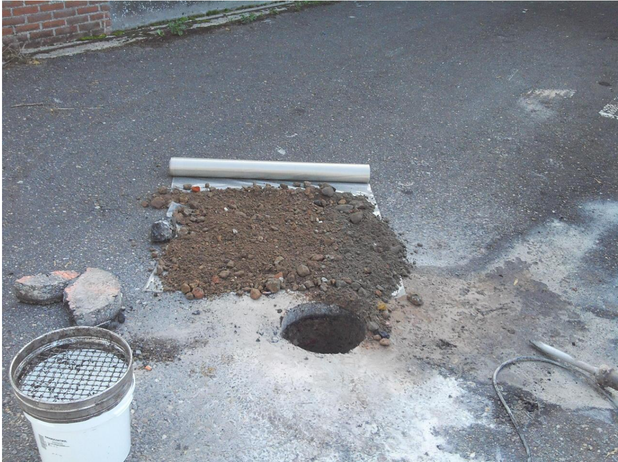
Foto 7: Zicht op asbestgat en hoedanigheid stabilisatie- en ophooglaag
