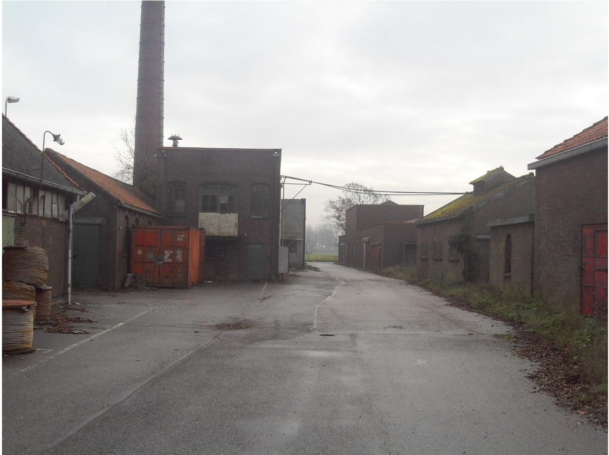
Foto 1: Zicht op voorzijde onderzoekslocatie
