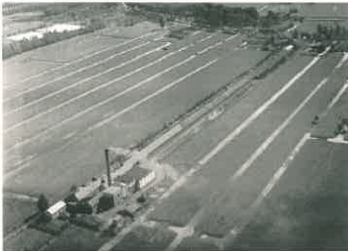
Luchtfoto van de touwfabriek (Aviodrome, foto nr. 008047r, 1928)
