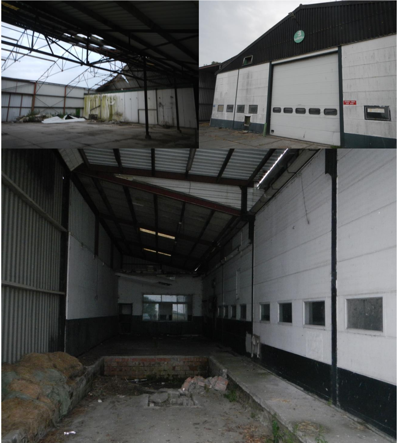
Figuur 2. Foto's planlocatie (De te slopen opstallen).
