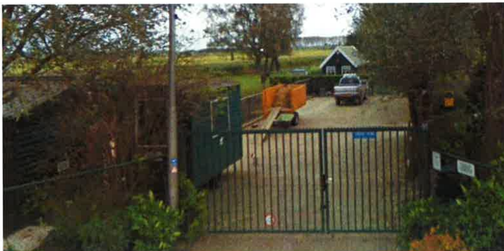
Figuur 4 foto bestaande gebouw
