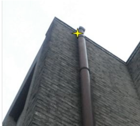
invlieglocatie achterzijde gebouw
