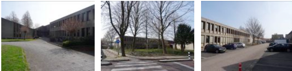
ligging (rood) en indrukken van het plangebied; hoofdingang van het voormalige gemeentehuis (linksonder), linkervleugel (midden), achterzijde van het gemeentehuis aan de Azaleastraat (rechts-onder) (luchtfoto: Google Earth)
