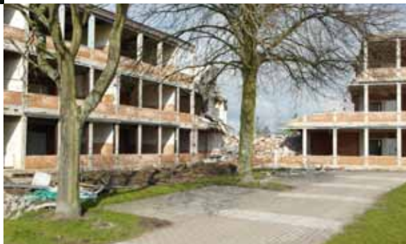
Fotobeelden van de sloop van een deel van het oude zorgcentrum De Egmontshof
