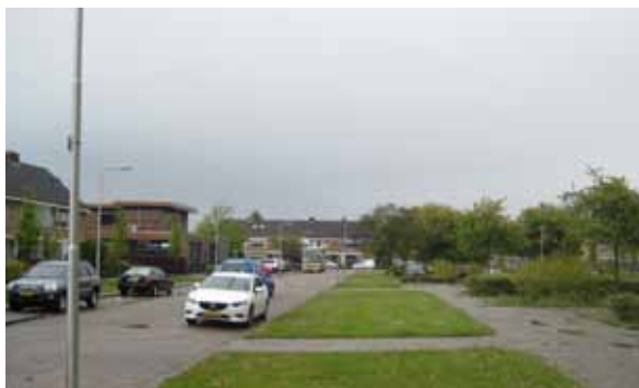
Parkeerterrein zijde Frans Halsstraat
