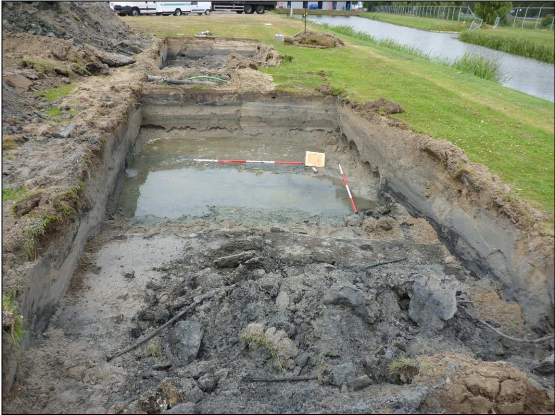
Figuur 18: Het vlak van werkput 9.
