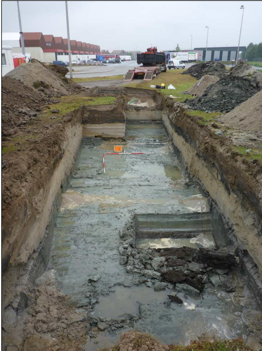
Figuur 16: Het vlak van werkput 7.
