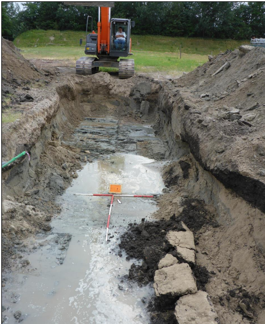
Figuur 13: Het vlak van werkput 6.
