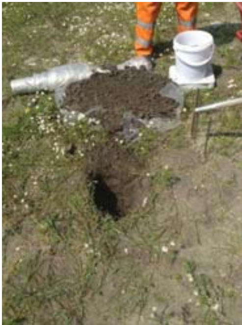
Verkennend asbestonderzoek deellocatie 1: A01
