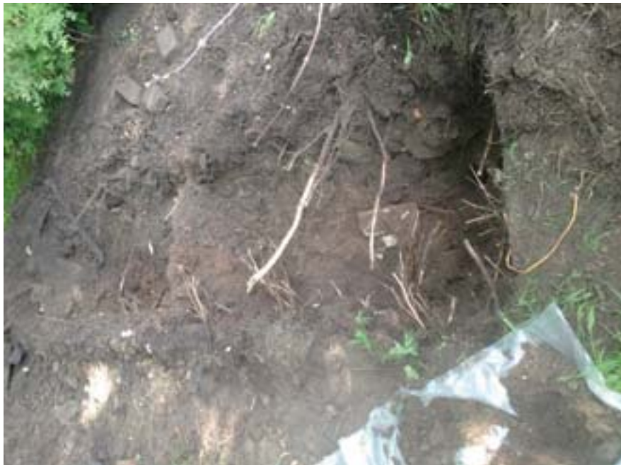
Nader asbestonderzoek deellocatie 2: SI01 (2 van 2)
