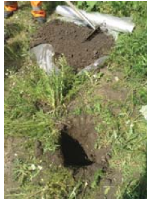
Verkennend asbestonderzoek deellocatie 1: A02
