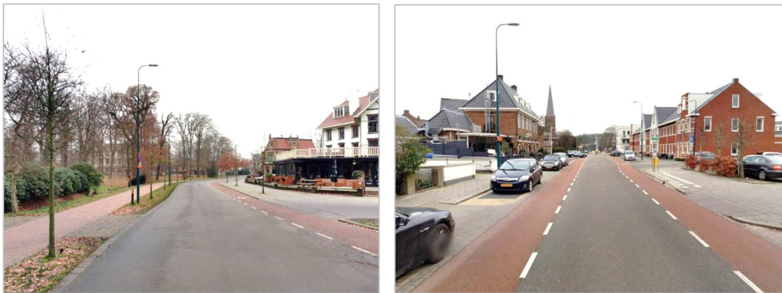
Figuur 4.5: Rhijngeesterstraatweg kent verschillende profielen, deels met vrijliggende fietspaden en deels met fietsstroken
