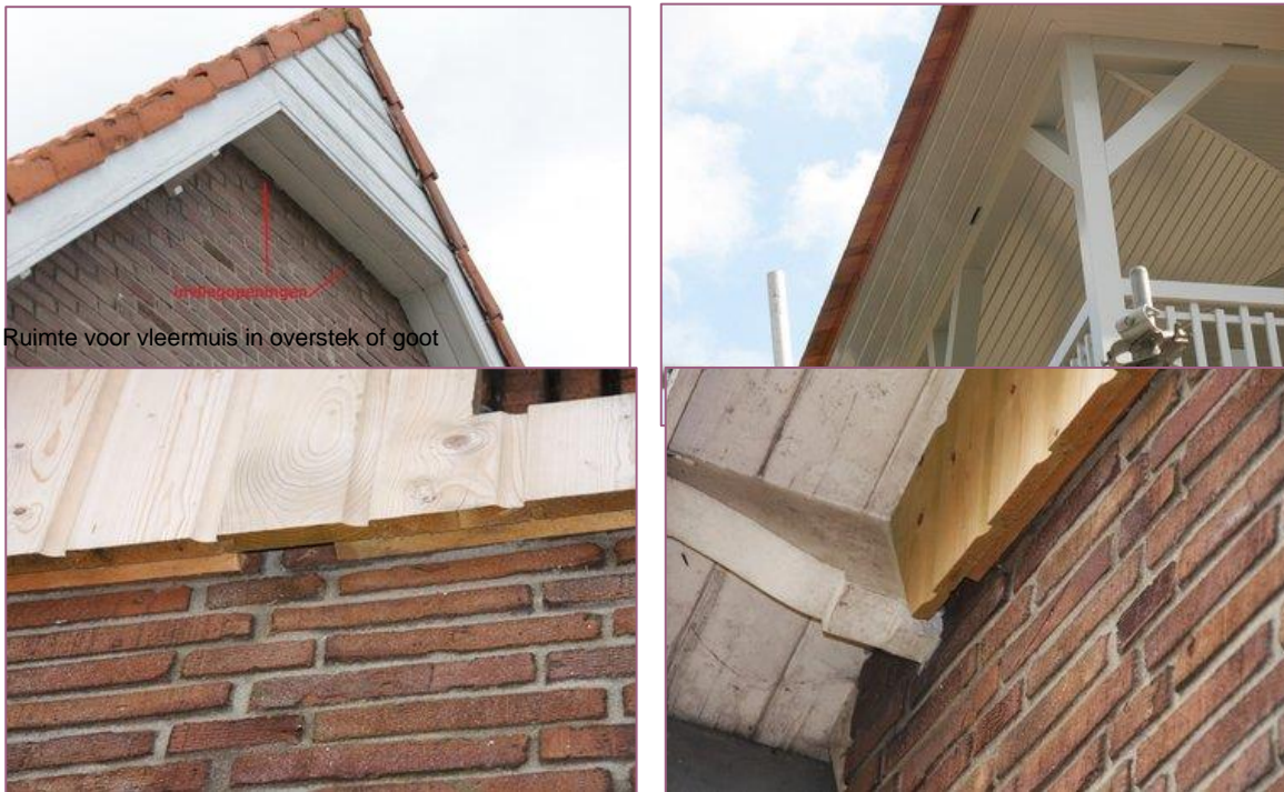
ruimte voor vleermuis achter gevelbetimmering
