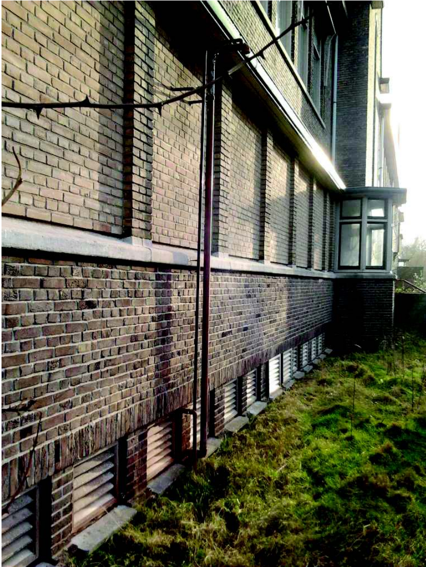
Foto 5: Tankontluchting te westen van het hoofdgebouw
