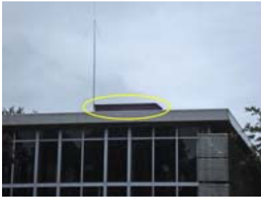
Figuur 4. Ketelhuis met locatie verblijfplaats Gewone dwergvleermuis.
