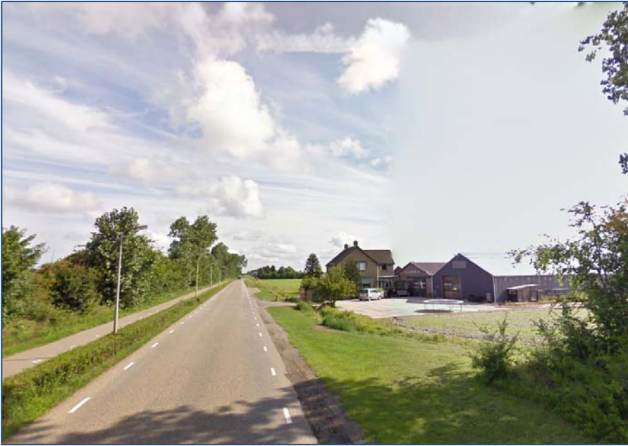
Afbeelding 2.1.: de Herenweg gezien in noordelijke richting. Bron: Google Maps
