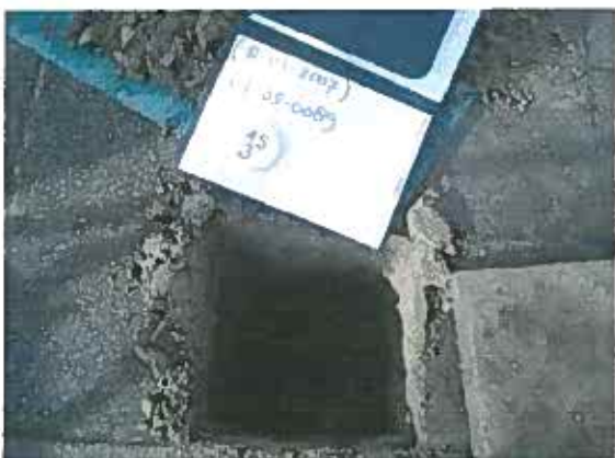
asbest-inspectiegat 03
