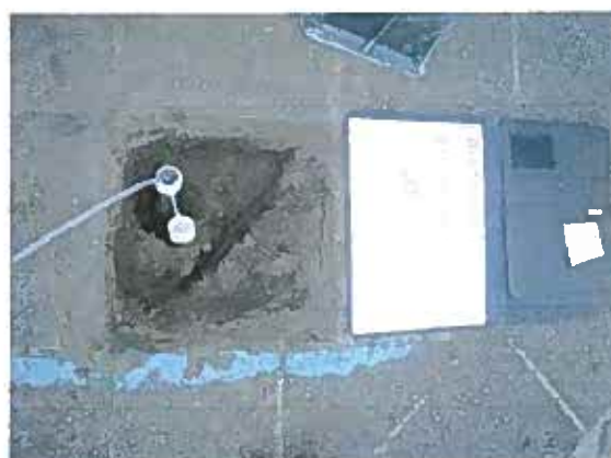
asbest-inspectiegat 05
