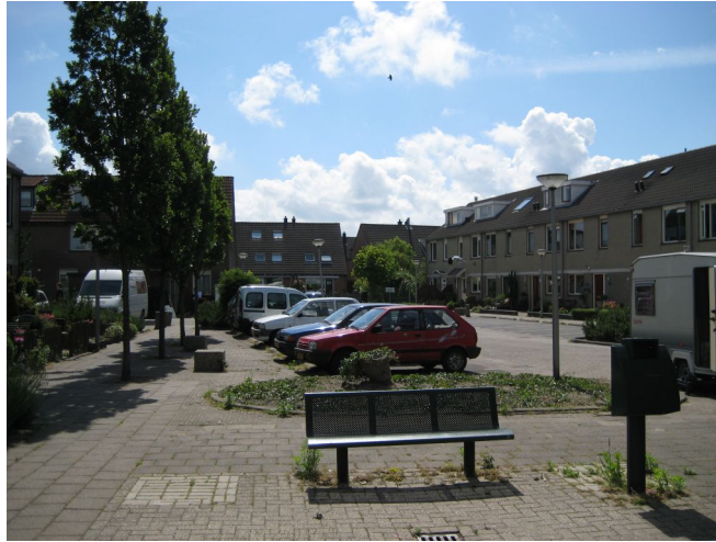
Afbeelding 11: Foto woonerf met centrale parkeervoorziening
