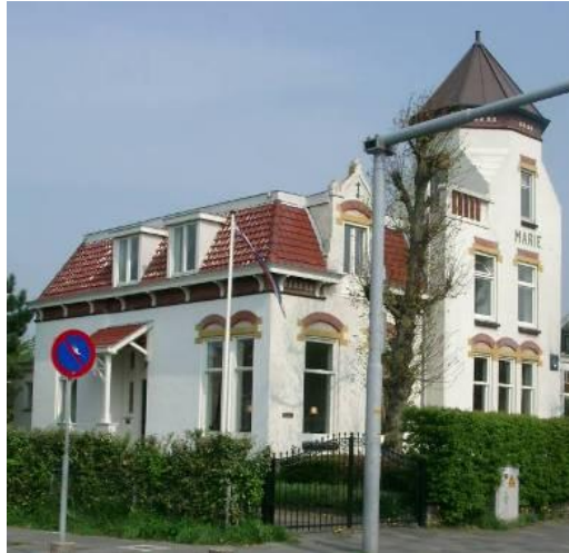
Pand op splitsing van Dompad en Lijnbaanweg
