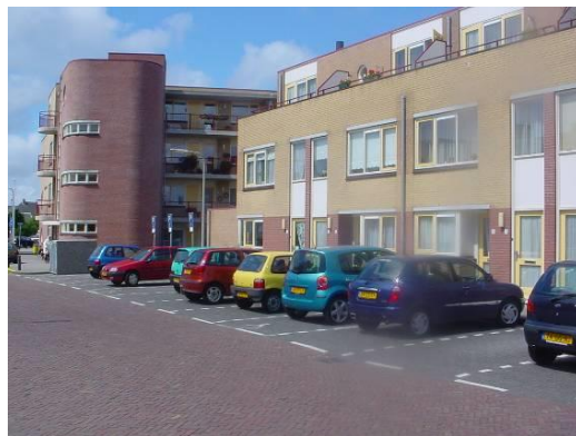
Afbeelding: gestapelde woningen aan de Hoogwakersbosstraat
