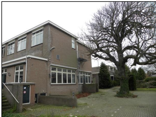
Pand hotel 'Hof van Holland' vanaf zuidzijde
