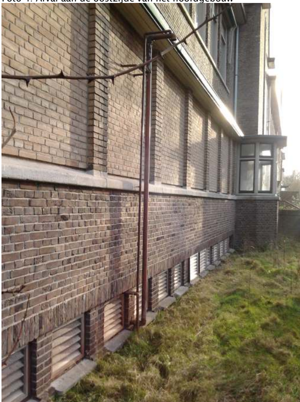
Foto 5: Tankontluchting te westen van het hoofdgebouw
