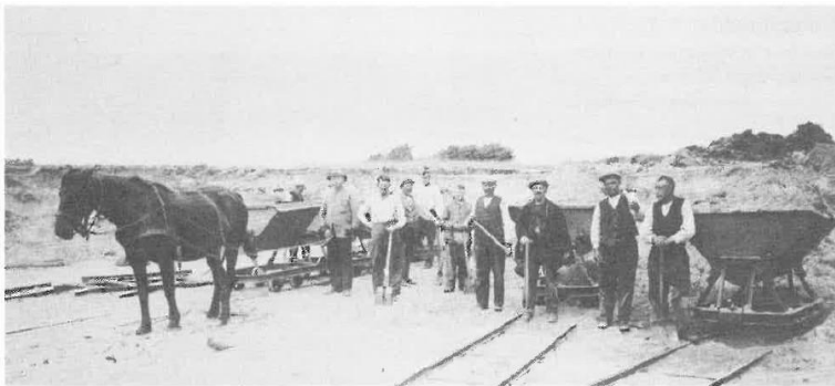
Figuur 6 zandafgravers egaliseren het duingebied. (bron: Van Dort – Clements 1988)
