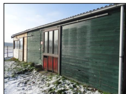
Figuur 8. Zijkant van de te slopen loods.
