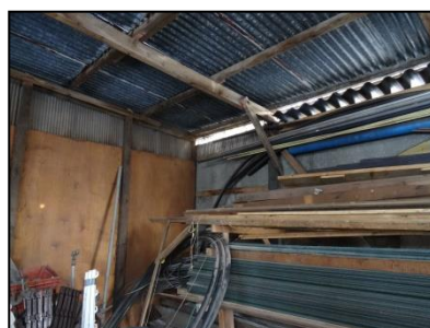
Figuur 7. Te slopen loods. Veelal opslag voor materiaal.
