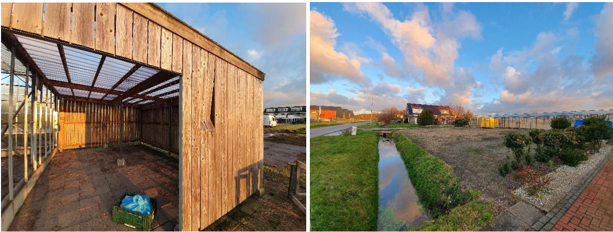
Fig. 5: Foto-impressie: links het houten schuurtje en rechts de greppel
