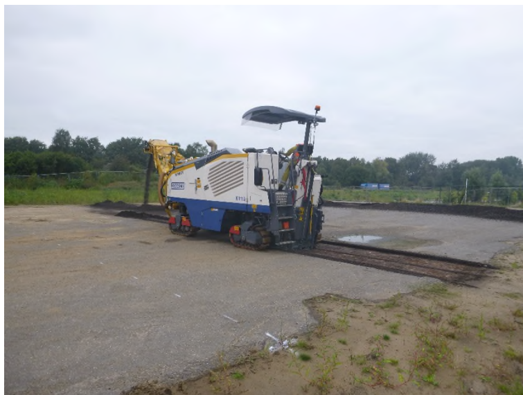
Afbeelding 2. Het verwijderen van het asfalt ter plaatse van werkput 1.
