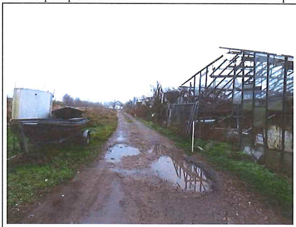
Foto 6: puinpad ten noordwesten van het kassencomplex
