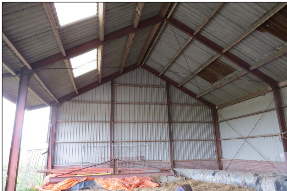
Open schuur met aluminium wanden en golfplaten dak.
