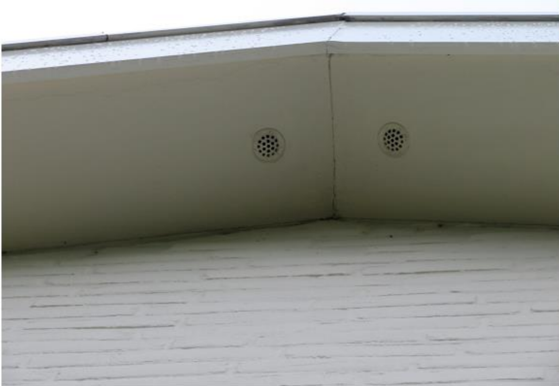
Bij de aansluitingen van het dak op de muur zitten geen kieren.
