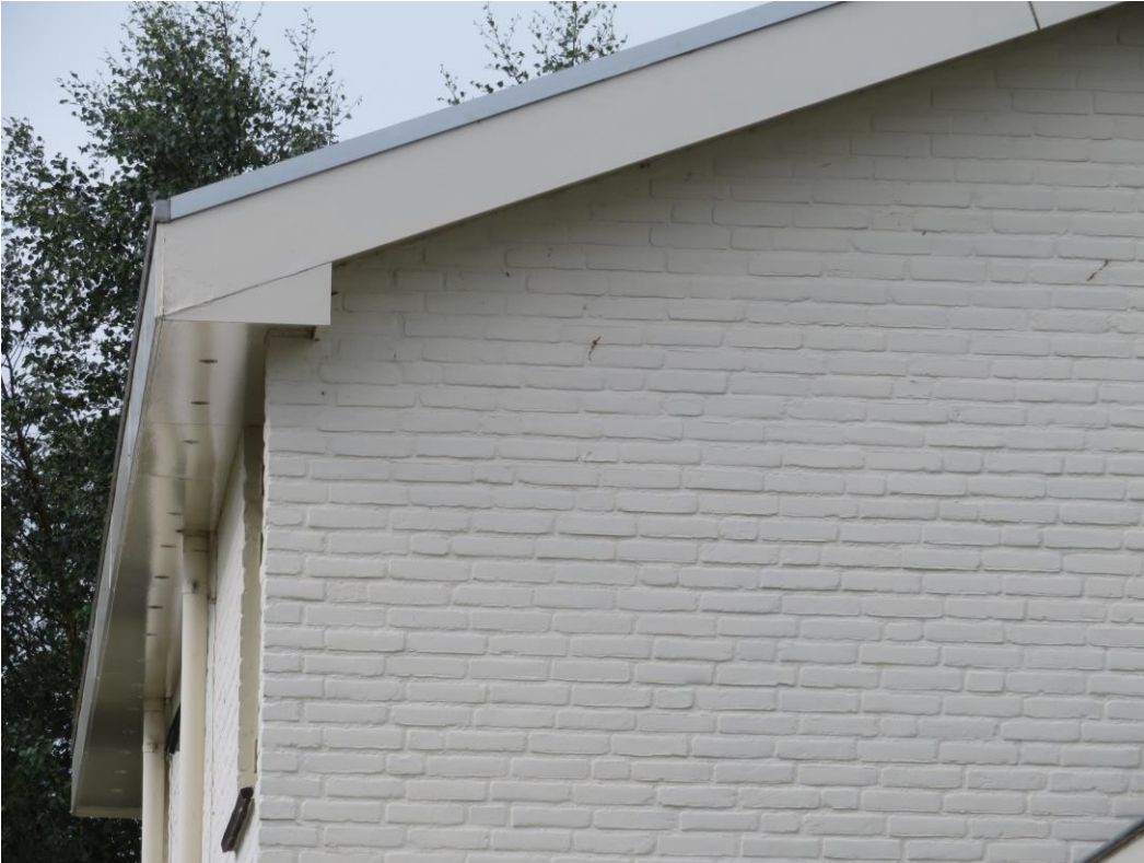
In de zijgevel zitten geen open stootvoegen.
