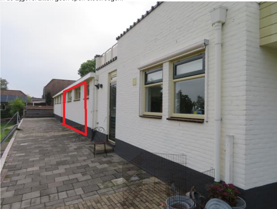
Globale locatie in de achtergevel waar de glazen pui wordt ingebouwd.
