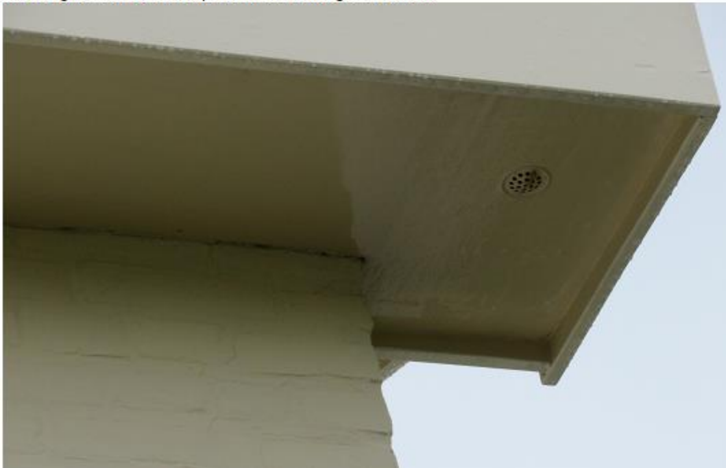
Bij de aansluitingen van het dak op de muur zitten geen kieren.
