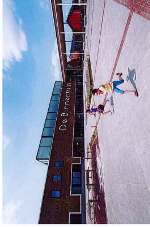
Verschillende bouwvolumes Utrecht, SVP Architectuur en Stedenbouw, foto Ronald Auée
