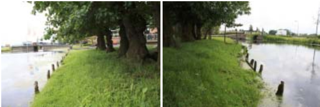
Rij knotelzen aan voorzijde perceel, langs de wetering. Hier is ook de vervallen oeverbescherming langs de wetering zichtbaar.
