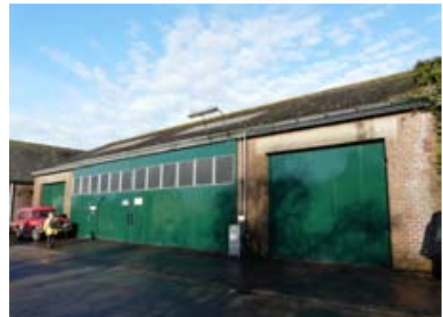
Zicht op de loods
