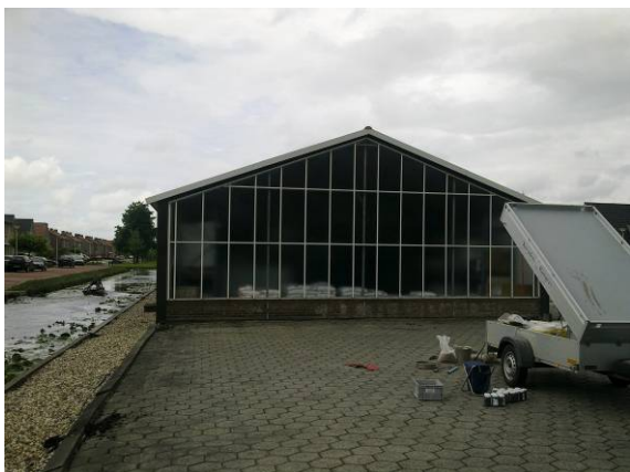
Foto 5: De zuidkant van de loods gezien vanaf de naastgelegen bedrijfswoning
