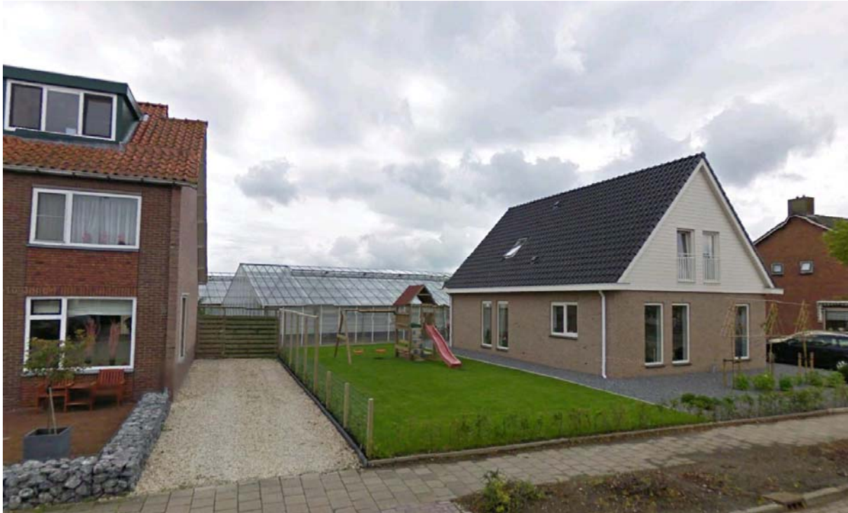
Locatie van de inrit. Op de achtergrond staan de bestaande kassen die plaats maken voor 3 woningen. Vanaf de Langerarseweg is in de toekomst weer zicht op de plas.
