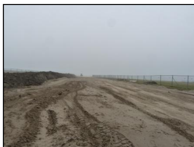
Figuur 7. Op een deel van de onderzoekslocatie hebben recent werkzaamheden plaatsgevonden.
