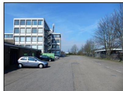
Figuur 5. Achterzijde hoofdgebouw
