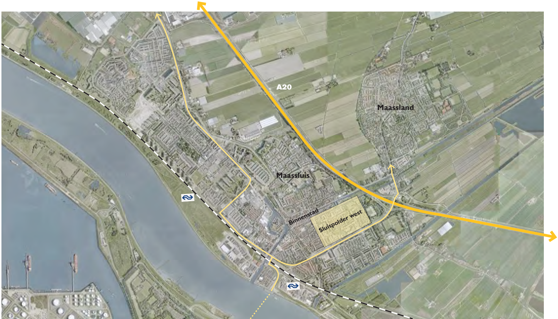
Sluispolder west in Maassluis
