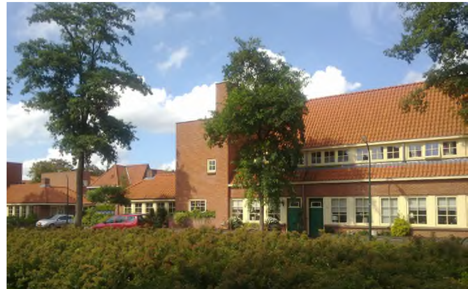
5b eenheid door materiaal gebruik, dakpan, gevelsteen en schilderwerk kozijnen
