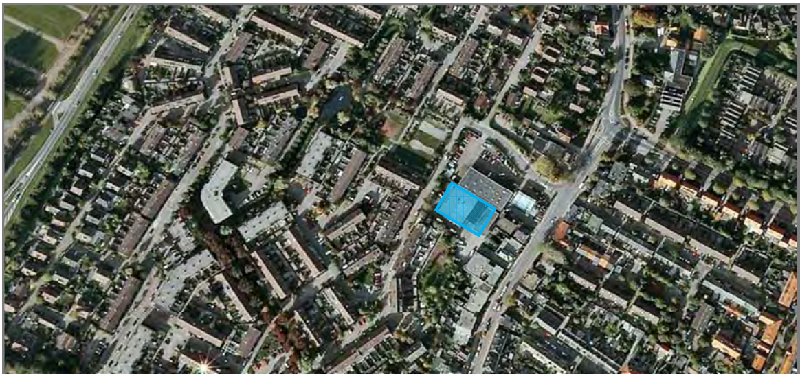
Afbeelding 3.1 | Luchtfoto van de huidige situatie met de te slopen bebouwing
