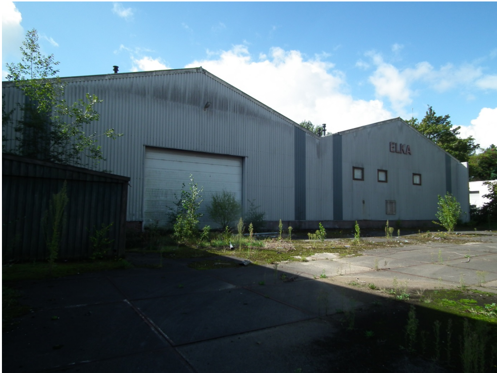
Figuur 1 De planlocatie is gelegen aan de Grevelingstraat 8 te Lisse. De locatie betreft het voormalig fabrieksterrein van Elka.
