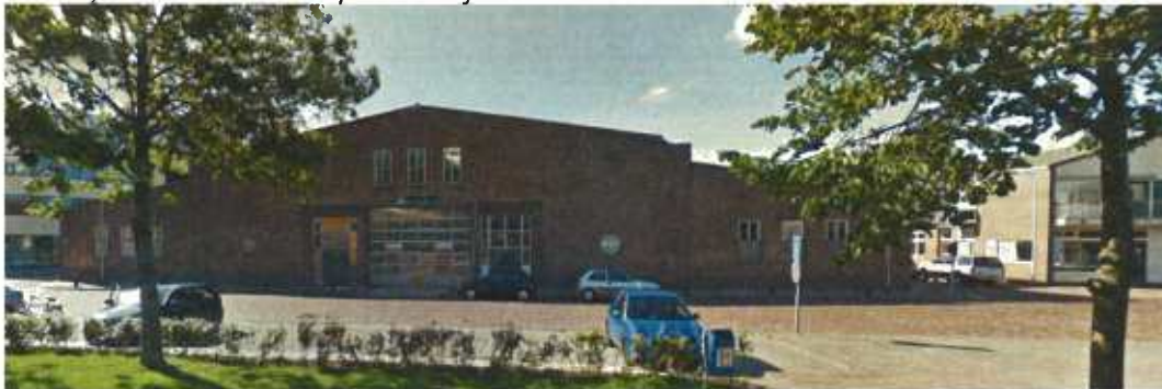
Foto 1, één van de te slopen bedrijfshallen
