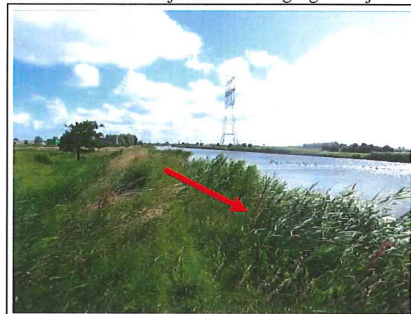
Foto 20: noordwestelijke oever watergang oostzijde locatie
