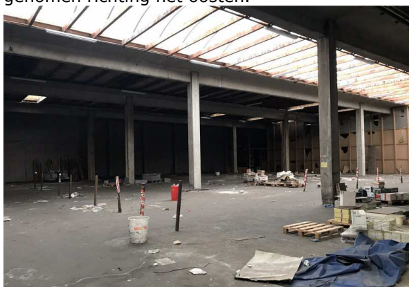
Figuur 15. De hal van de tegelzetterij, met de lichttunnels in het plafond.
