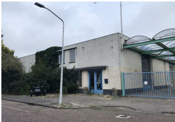
Figuur 5. Zicht op de voormalige stomerij, gezien vanaf de Bloemistenlaan.
