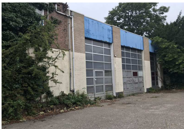
Figuur 3. Oostelijke zijde van de voormalige stomerij. Foto genomen richting het noorden.
