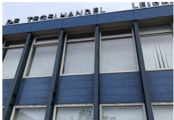
Figuur 14. Detail van de bouwstijl van de tegelzetterij.
