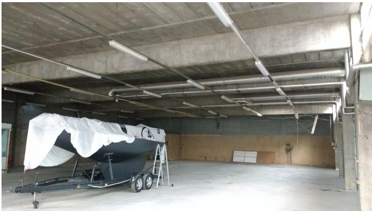
Figuur 6. Situatiefoto richting het zuidwesten vanuit de noordoostelijke hoek van de oostelijk gelegen loods.
