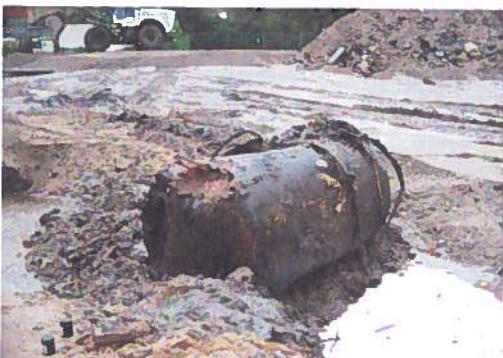
Foto opname deellocatie B, van de opgegraven tank
