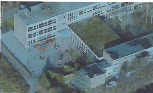
Foto opname deellocatie A voor de sloop
