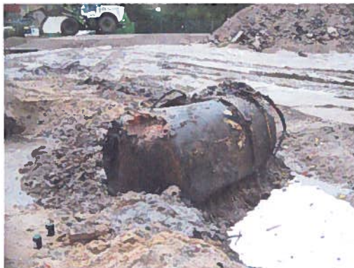
Foto opname van de tank
