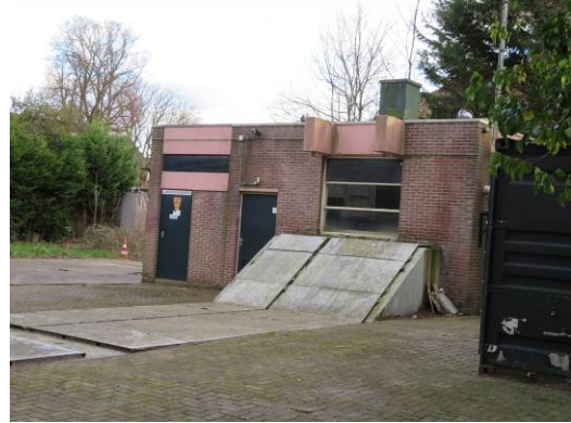
Foto 2: aanzicht Lammenschansweg 2 (rioolgemaal).
