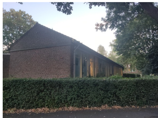
Foto 6: aanzicht zuidelijke deel van nr. 6.
