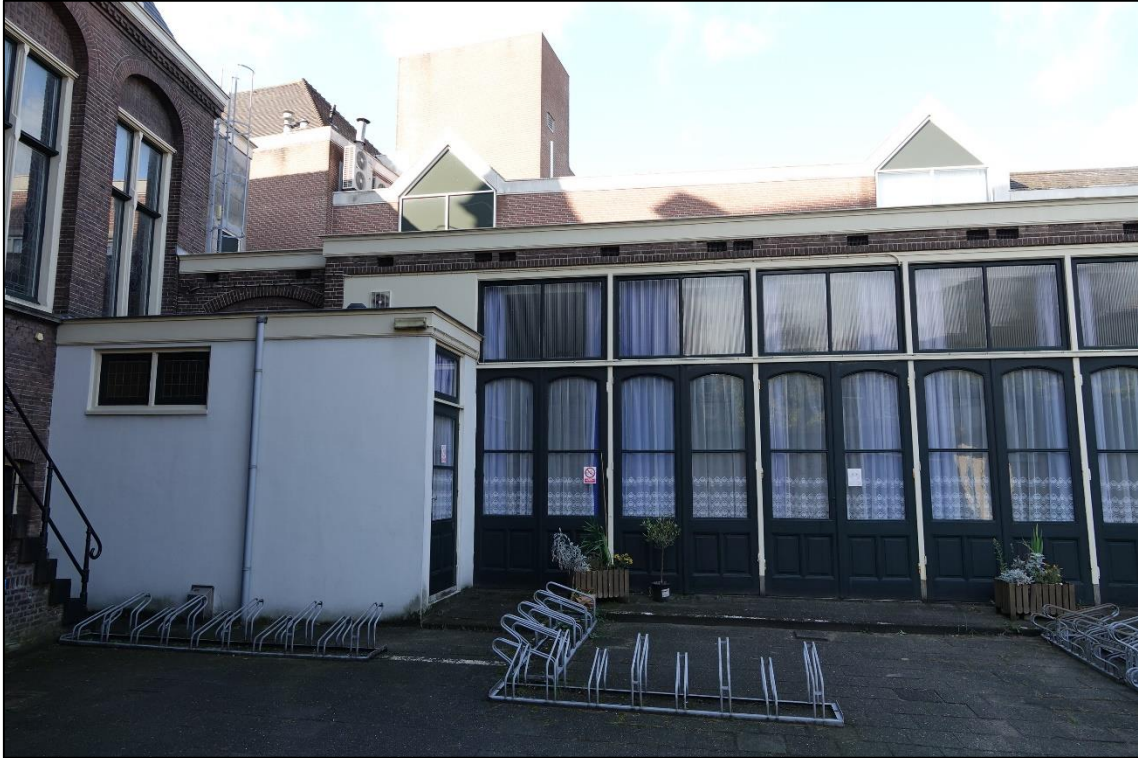
Figuur 9: De gevel van de parochiezaal. De dakrand bevat meerdere openingen welke toegankelijk zijn voor gebouwbewonende vleermuissoorten.
