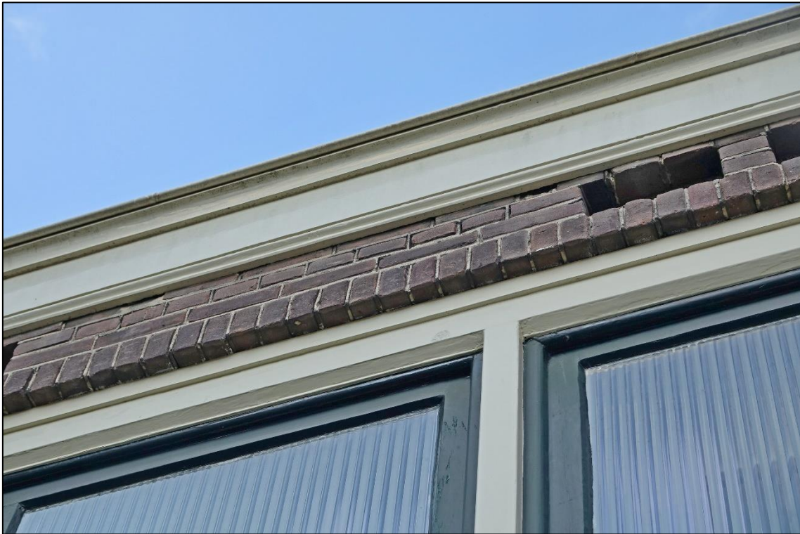
Figuur 10: Close-up van de dakrand van de parochiezaal. Te zien zijn voorbeelden van openingen en kieren waar vleermuizen het gebouw binnen kunnen vliegen.
