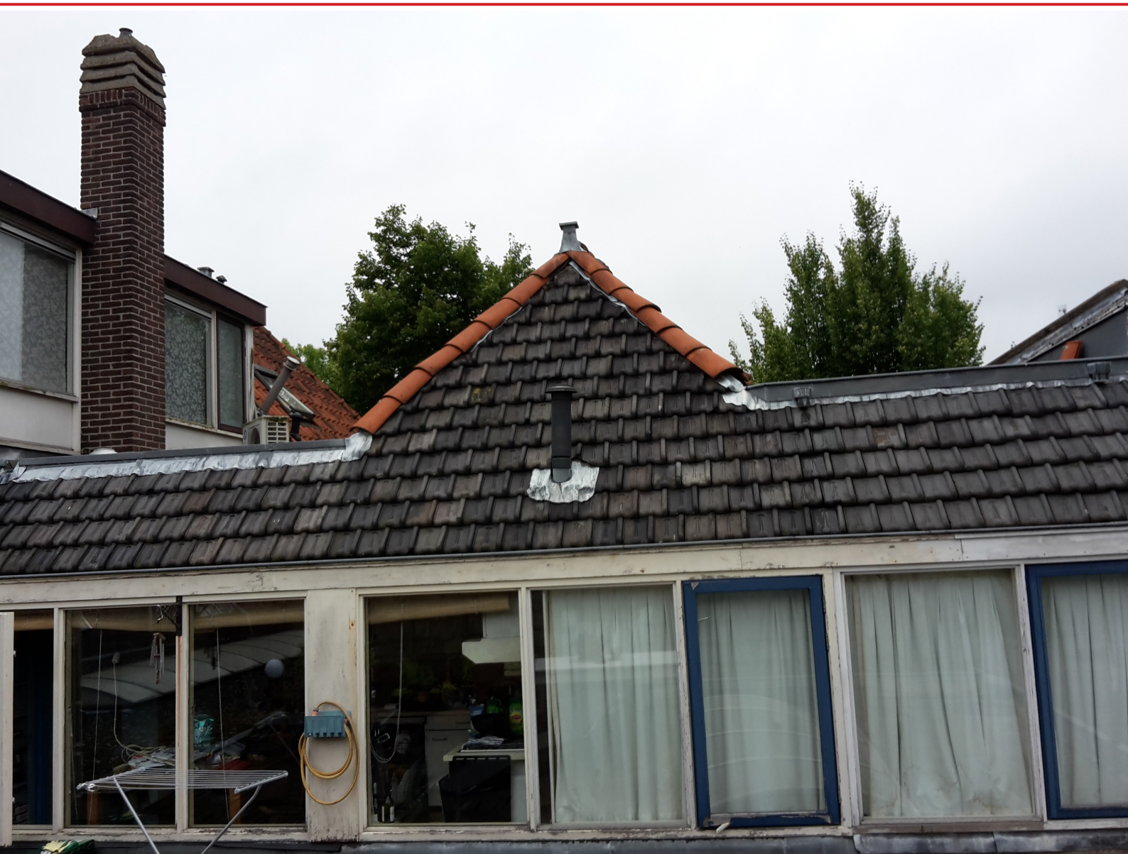
Dakgedeelte met dakpannen
